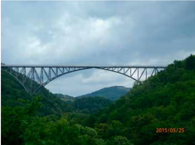
Viaduc du Viaur (steel)
